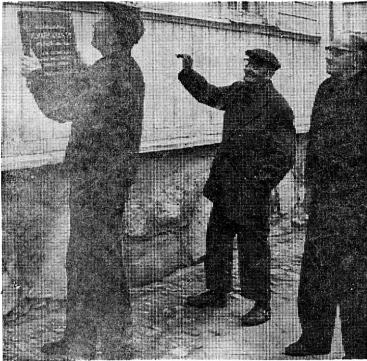
Isä Kustaa ja poika Heikki Lipponen seuraavat laatan kiinnitystä seinään. Kiinnittäjänä kivimestari J. Heikki-nen.
